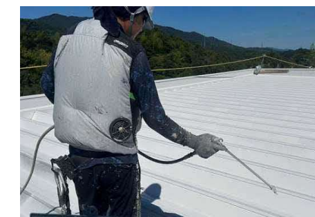
工場屋根の遮熱塗装施工
