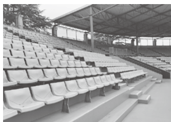
◀野球場メインスタンド防水対策完成写真
