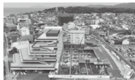
第2期棟工事の様子
