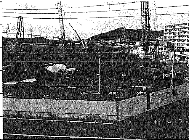
写真6. 拠点施設整備区域
