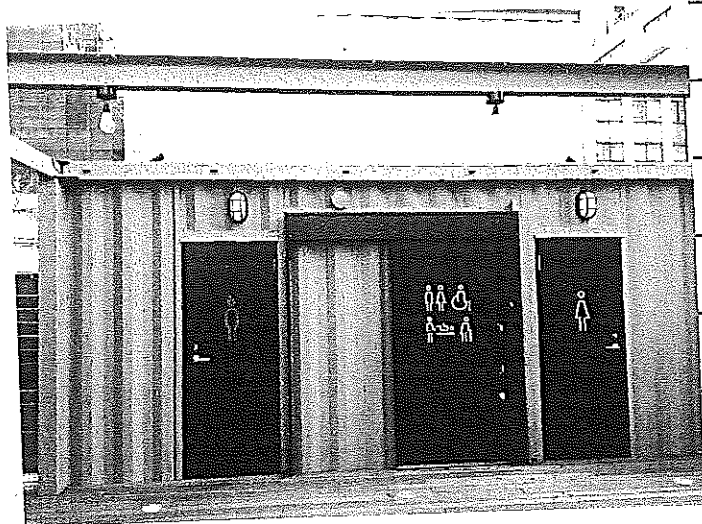
写真5. 新設のトイレ
