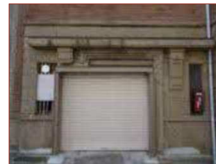
北側入口鉄骨フレーム補強
