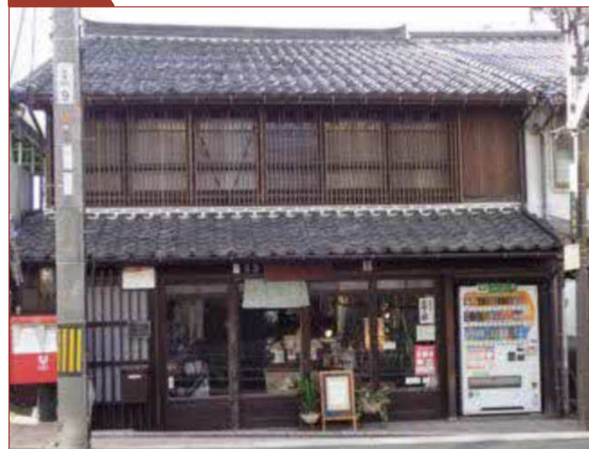
東側（正面） 屋根修繕、2階開口部修繕 格子取付
