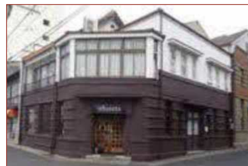
外壁洗浄、塗装
