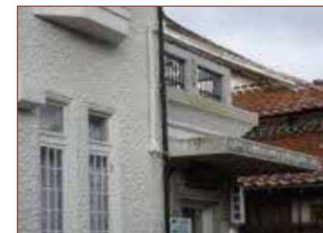
外壁洗浄、塗装
