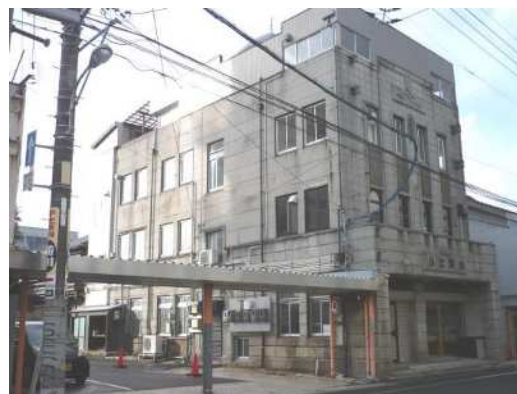
◆出雲ビル〔白潟本町〕 【松江市登録歴史的建造物 第1号】
