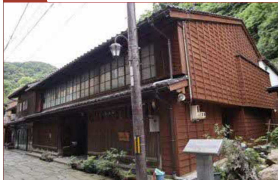
東側外壁塗装
