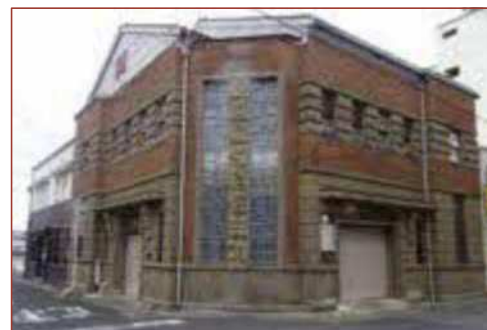
外壁洗浄、塗装
