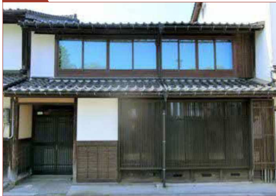
東側（正面） 耐震補強、建具改修等
