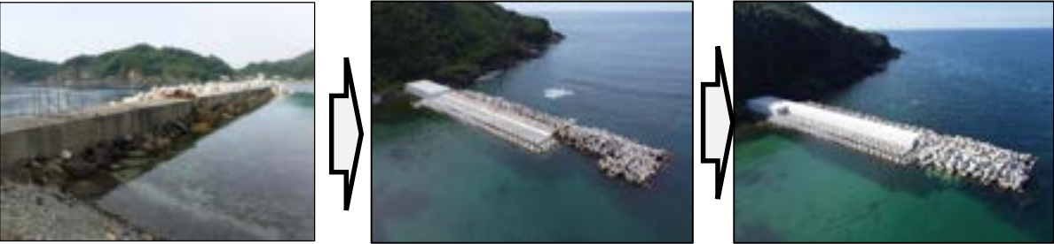
整備前 (R4.3) 着手前 (R5.3) 竣工 (R5.11)
