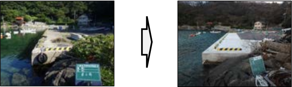
着手前 (R3.8) 竣工 (R4.1)
