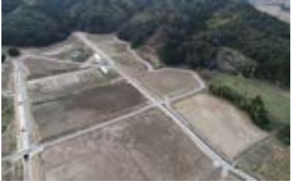
R2 工事完成区画
