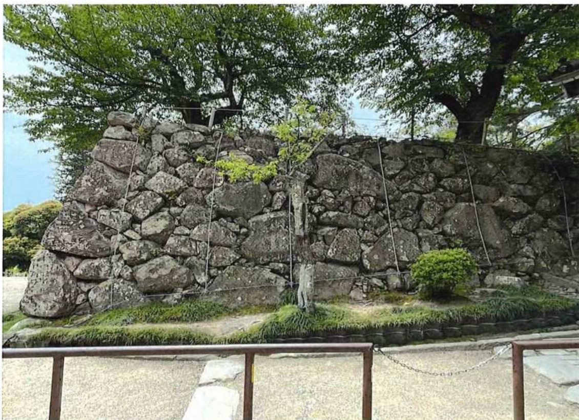
松江城での落石ネット施工例(一之門前、弓櫓下石垣)
