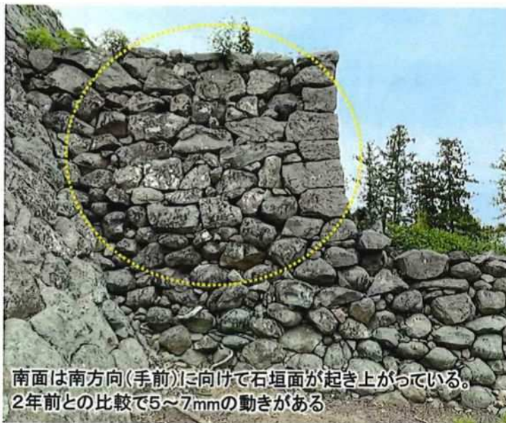
【石垣定点観測の結果】 令和5年6月と、2年前との比較 (南面)南側に5~7mm動きあり (東面)ほぼ動きなし
