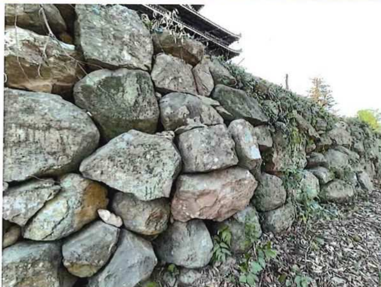
東面は東方向(手前)に向けて石垣面が孕んでいる。 2年前との比較で変動は進んでいないが変形が著しい状況
