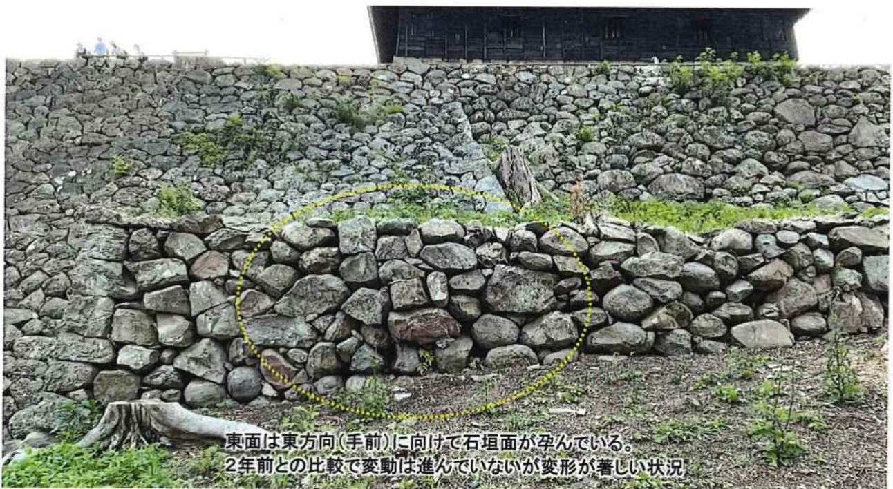
南面は南方向(手前)に向けて石垣面が起き上がっている。 2年前との比較で5~7mmの動きがある
