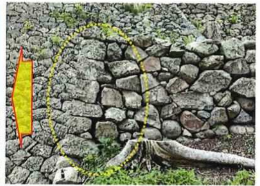
【石垣定点観測の結果】 令和5年6月と、2年前との比較 (南面)南側に5~7mm動きあり (東面)ほぼ動きなし
