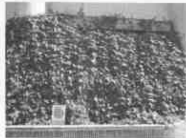
【グリーンカーテン】 場所：松江市環境センター
