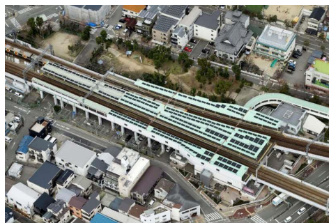
大物駅に導入された太陽光発電 (148.5kW)
