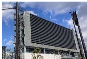
スコアボード裏 太陽光発電設備(26kW)
