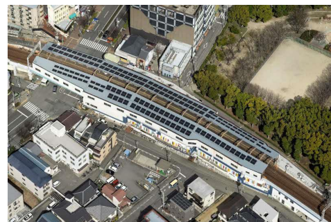
杭瀬駅に導入された太陽光発電 (143kW)
