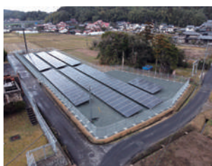
太陽光発電導入事例 (竹矢ポンプ場)
