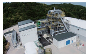
木質バイオマス発電所 (松江バイオマス発電株式会社)
