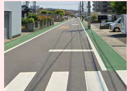
【路側帯カラー舗装】
