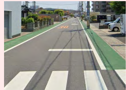
【路側帯カラー舗装】
