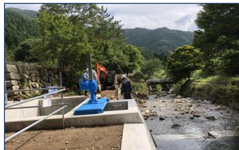
■除塵器:国内実導入2例目となる水車連動型自動除塵器、ゴミを取る手間が省けて発電効率アップ
