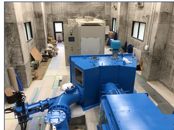
■水車:ターゴ型、水量の変化に比較的強い、導入コストもフランシス型(めぐみ)に比較すると安価
