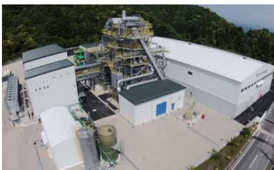
【木質バイオマス発電所（松江バイオマス発電株式会社）】
