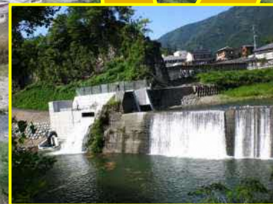
小水力発電所
