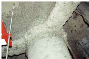
柱や梁に施工 吹付け石綿
