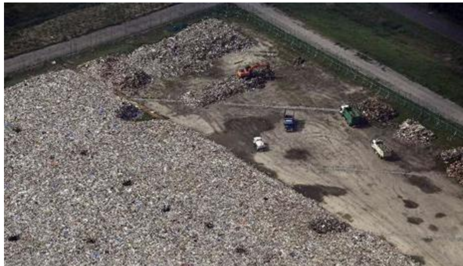
平成30年7月豪雨災害倉敷市内の二次仮置場(被災地外)
