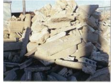
コンクリートがら
