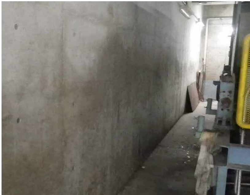
エコステーション松江 粗大ごみ処理施設棟 漏⑩（内部漏水部） 外部からの漏水（推測） コンベヤピットD 北面 B1F-DE-⑦～⑨
