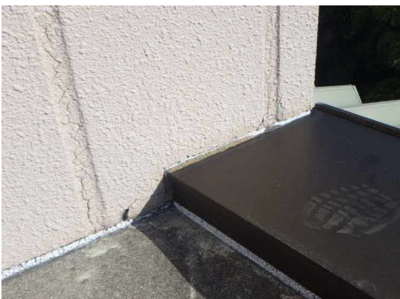
エコステーション松江 不㉑ (屋根不具合箇所) 板金、笠木。ALC取合部 シーリング劣化、亀裂 FL+11.0M
