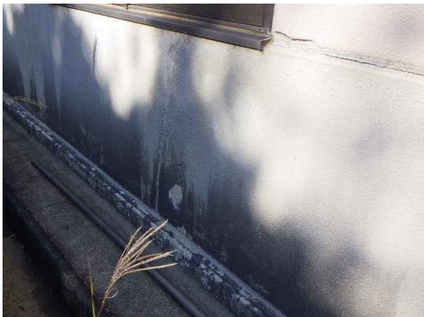
エコステーション松江 粗大ごみ処理施設棟 ④④ (南面) □ALC壁面欠損状況 ②-①通り間 (拡大)
