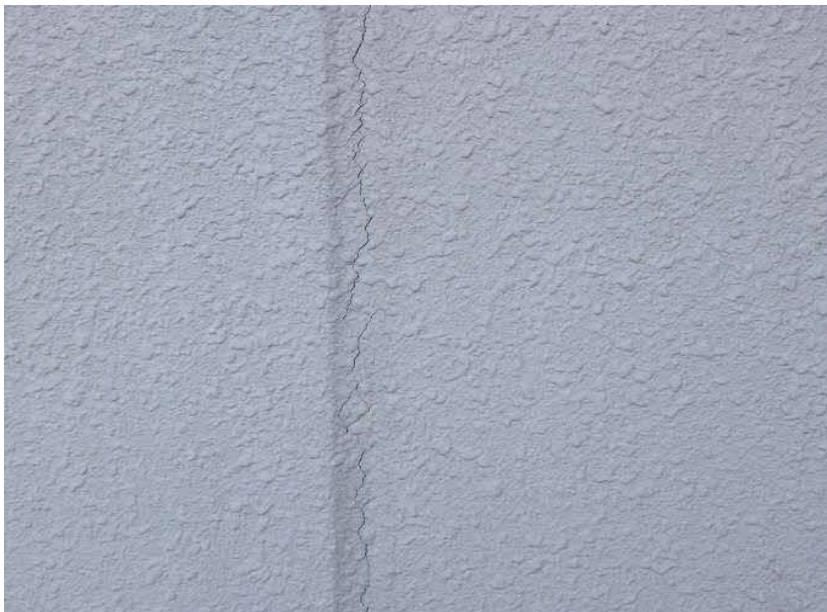
エコステーション松江 粗大ごみ処理施設棟 ⑭ (北面) □ALC壁面クラック状況 ⑧-⑪通り付近 (拡大)
