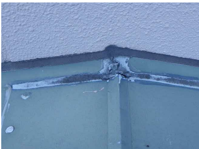
エコステーション松江 不⑱（屋根不具合箇所） 板金接合部 シーリング亀裂、硬化 （共通）
