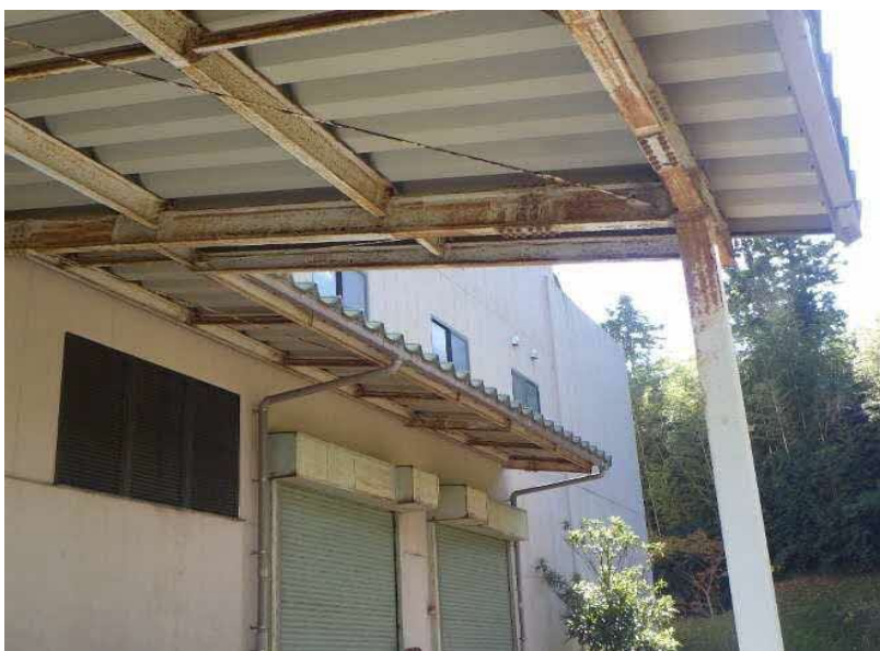
エコステーション松江 粗大ごみ処理施設棟 不③（屋根不具合箇所） 鉄骨部の発錆（共通） 西面底部（見上げ）
