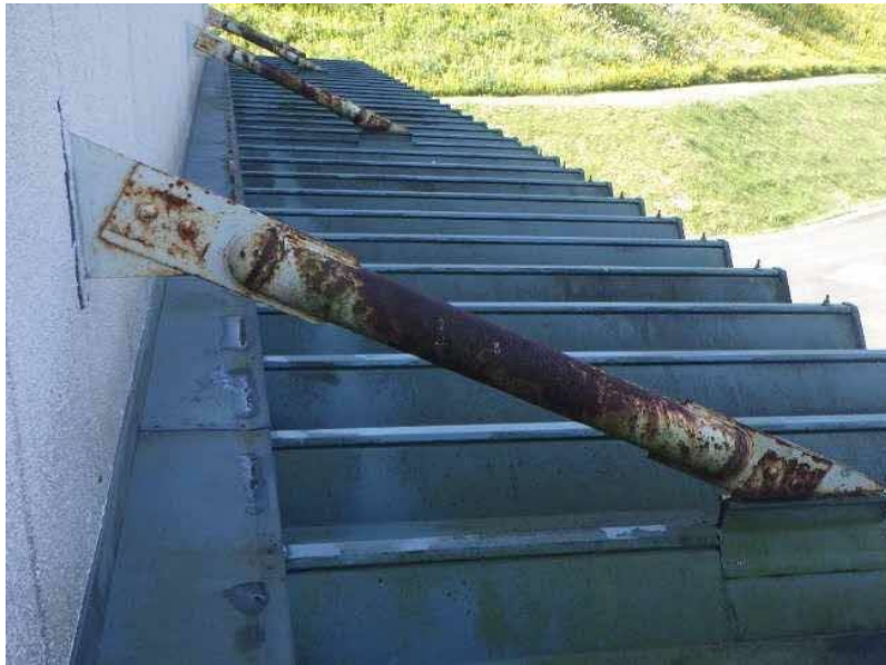
エコステーション松江 粗大ごみ処理施設棟 不①（屋根不具合箇所） 鉄骨部の発錆（共通） 北面底部
