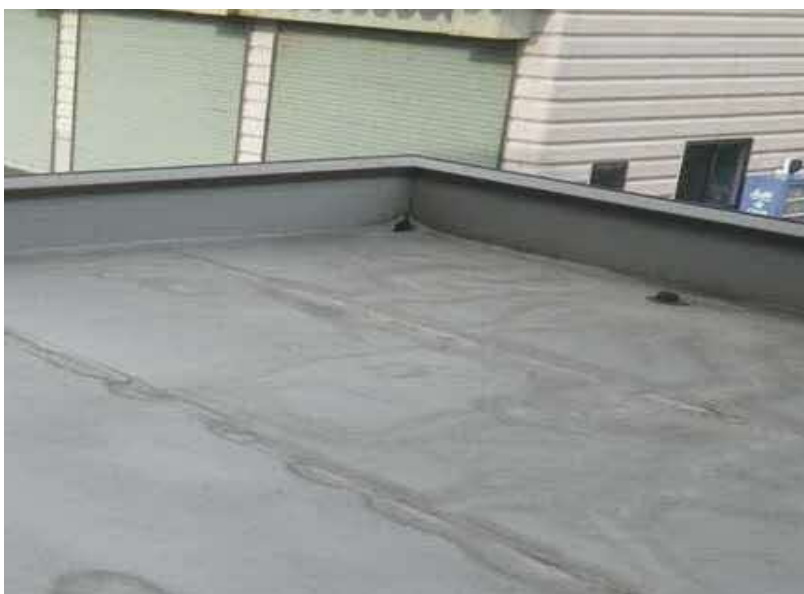
エコステーション松江 粗大ごみ処理施設棟 不⑥（屋根不具合箇所） コーナー部防水剥離 ポーチ屋根
