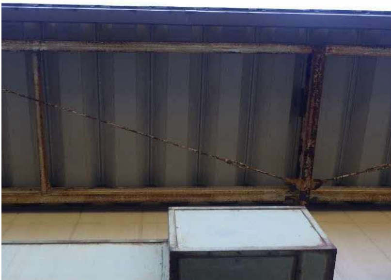
エコステーション松江 粗大ごみ処理施設棟 不②（屋根不具合箇所） 鉄骨部の発錆（共通） 北面底部（見上げ）
