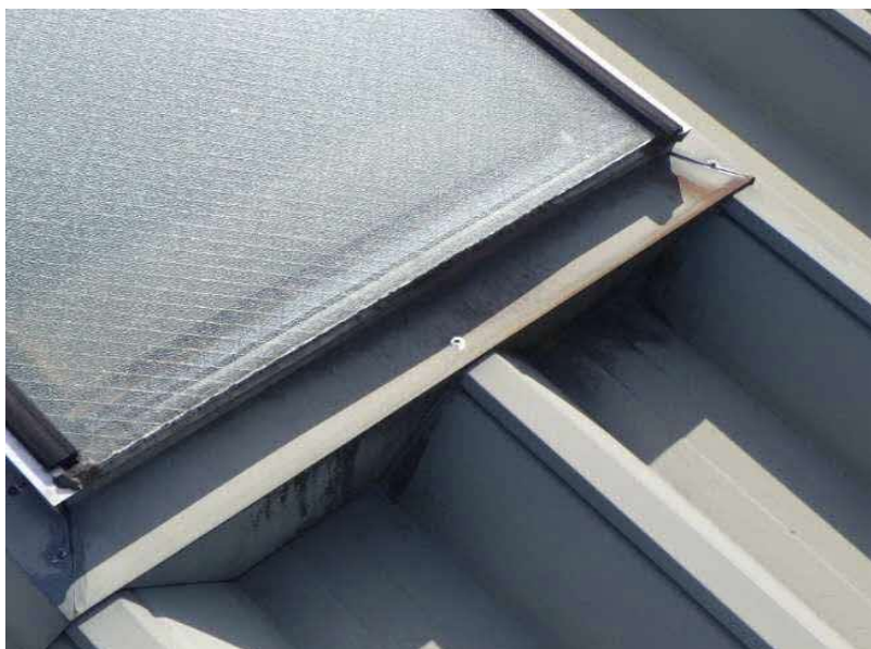
エコステーション松江 不㊸ (屋根不具合箇所) トップライト 周囲止水ゴム欠損 (共通)
