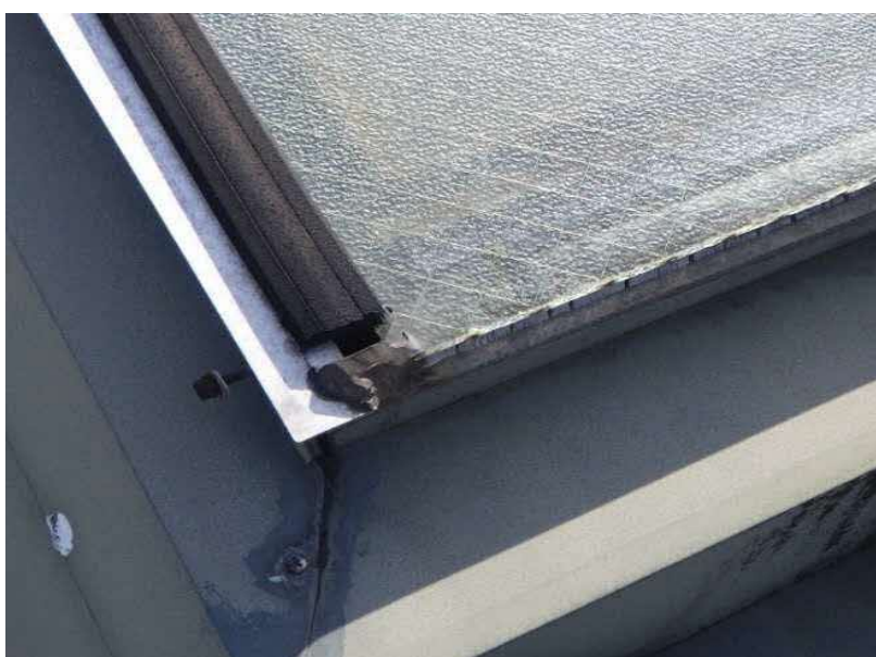
エコステーション松江 不㊹ (屋根不具合箇所) トップライト 周囲止水ゴム欠損 (共通)
