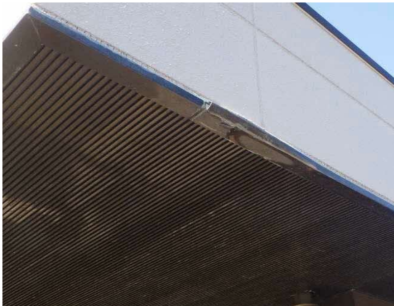
エコステーション松江 粗大ごみ処理施設棟 ⑤ (東面) □ポーチ軒天破損部 (拡大)
