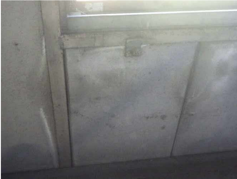
エコステーション松江 粗大ごみ処理施設棟 漏④（内部漏水部） シーリング部からの漏水 （ALC板、AW） FL+6.0M付近 （共通）
