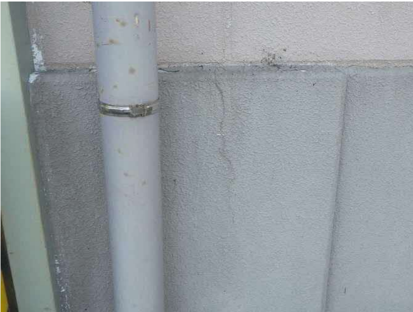
エコステーション松江 粗大ごみ処理施設棟 ⑩ (北面) □RC壁面クラック状況 ⑤通り付近 (拡大)
