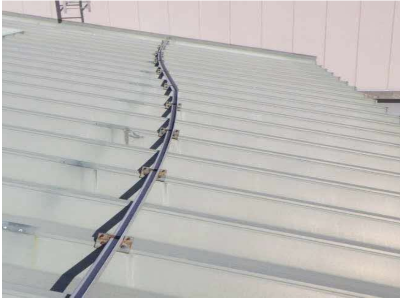
エコステーション松江 不②⑥（屋根不具合箇所） 雪止め金物変形 FL+11.0M南屋根
