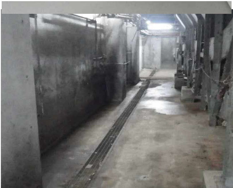
エコステーション松江 粗大ごみ処理施設棟 漏⑬（内部漏水部） 外部からの漏水（推測） コンベヤピットC B1F-E-⑥～⑦
