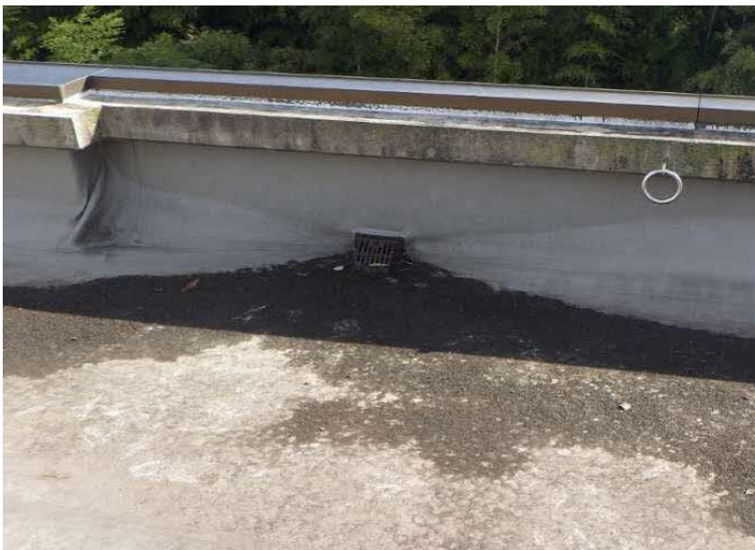
エコステーション松江 不⑮（屋根不具合箇所） 入隅部防水剥離 （全般） ルーフトレイン部 土砂の堆積 防水剥離 FL+11.0MM
