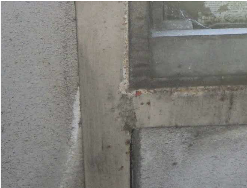
エコステーション松江 粗大ごみ処理施設棟 漏⑤（内部漏水部） シーリング部からの漏水 （ALC板、AW） FL+6.0M付近 （共通）
