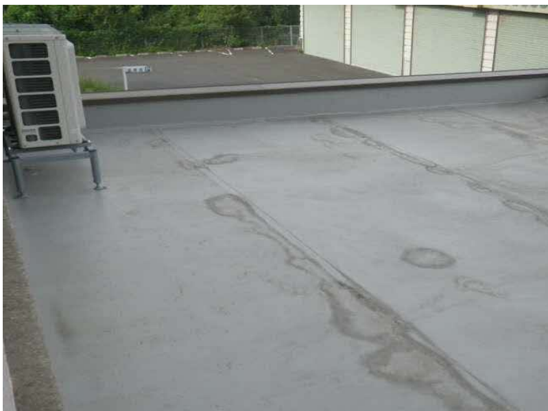
エコステーション松江 粗大ごみ処理施設棟 不⑤（屋根不具合箇所） 室外機設置不良 防水層へ直接設置 ポーチ屋根
