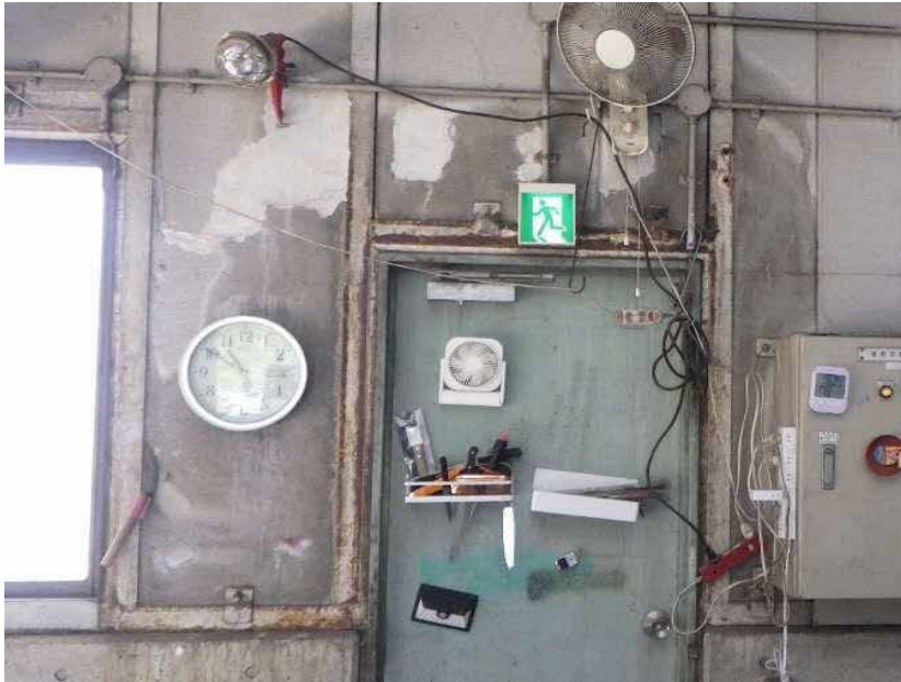
エコステーション松江 粗大ごみ処理施設棟 漏①（内部漏水部） シーリング部からの漏水 （ALC板、AW、SD） 1F-F-③-④
