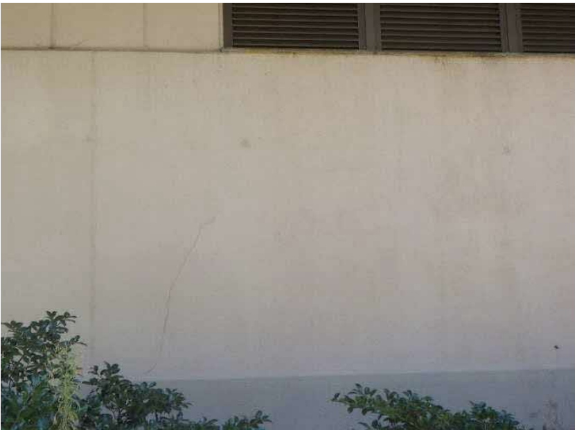
エコステーション松江 粗大ごみ処理施設棟 ②⑥ (西面) □RC壁面クラック状況 C通り付近 (拡大)
