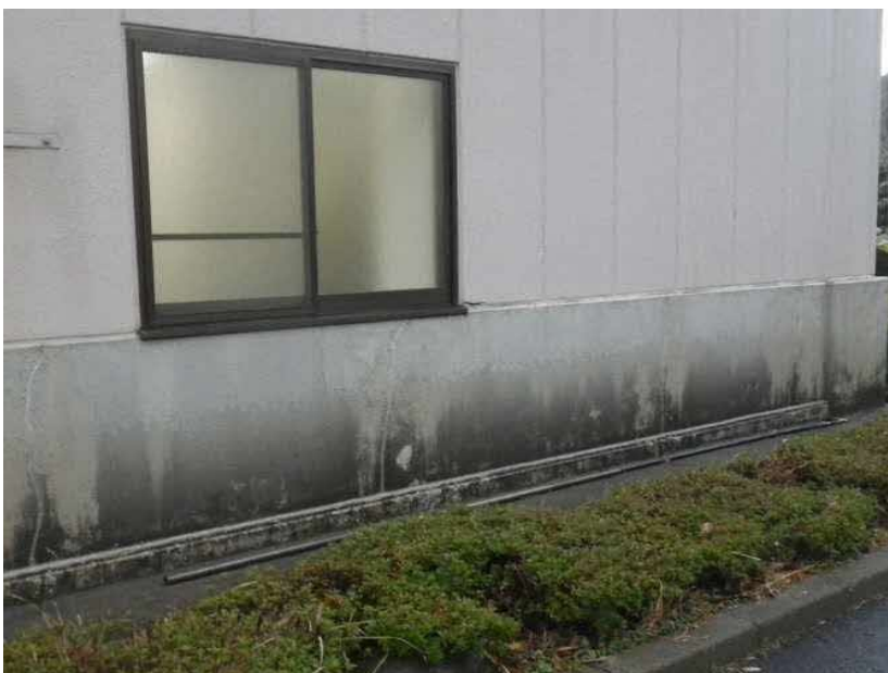
エコステーション松江 粗大ごみ処理施設棟 ④③ (南面) 腰壁 □RC壁面クラック状況 ②-①通り間
