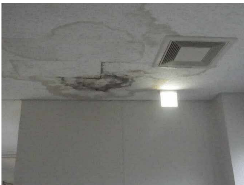
エコステーション松江 粗大ごみ処理施設棟 漏⑨（内部漏水部） 屋根からの漏水跡
