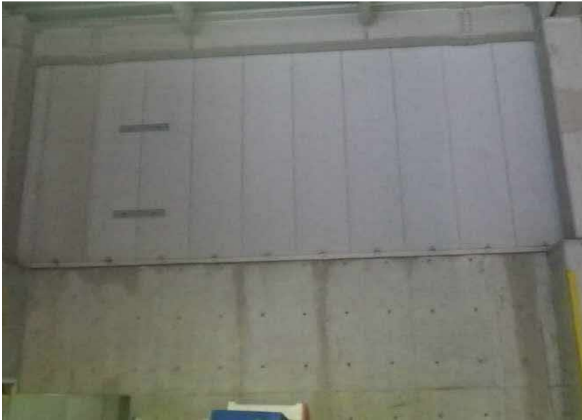
エコステーション松江 粗大ごみ処理施設棟 漏②（内部漏水部） シーリング部からの漏水 （ALC板） 1F-①-A-B間
