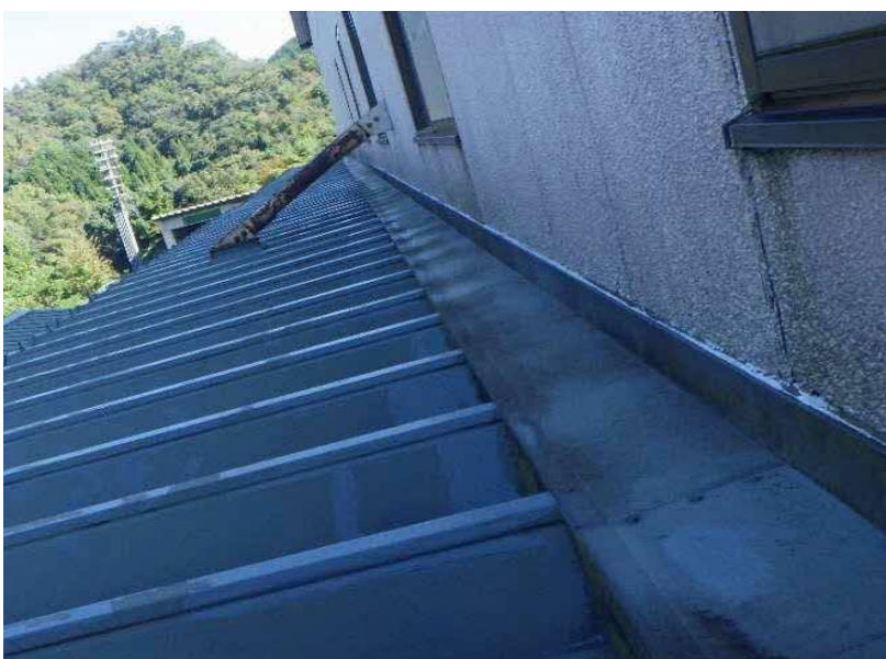
エコステーション松江 不㉒ (屋根不具合箇所) 板金、ALC取合部 シーリング劣化、亀裂 (共通)
