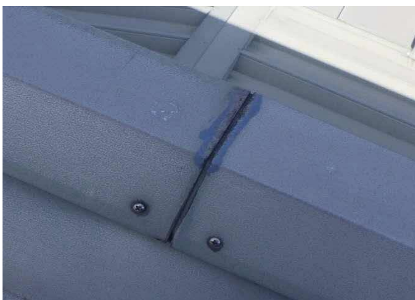
エコステーション松江 不⑲（屋根不具合箇所） 接合部シーリング欠損 （共通）
