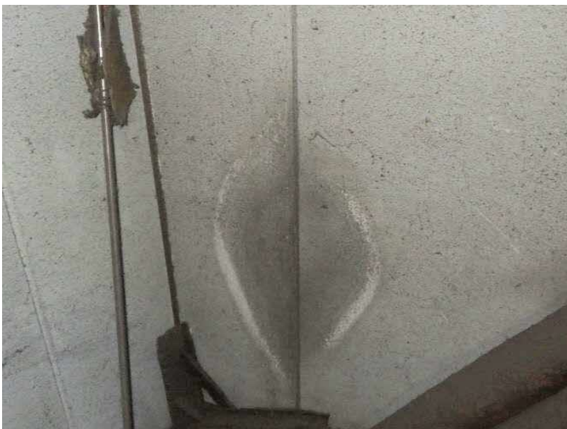
エコステーション松江 粗大ごみ処理施設棟 漏⑥（内部漏水部） シーリング部からの漏水 （ALC板） （共通）
