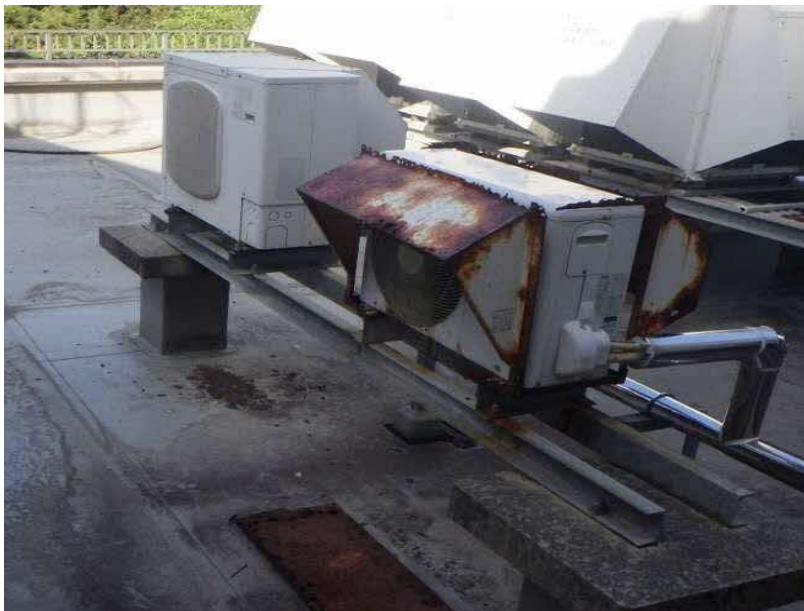
エコステーション松江 不⑫（屋根不具合箇所） 設備機器破損放置 FL+7.0M
