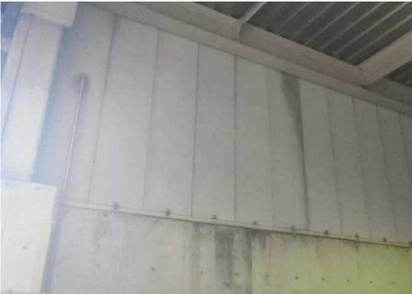
エコステーション松江 粗大ごみ処理施設棟 漏③（内部漏水部） シーリング部からの漏水 （ALC板） 1F-A-②-①間
