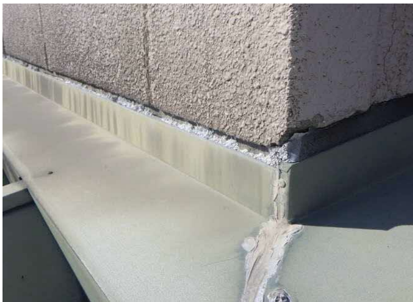
エコステーション松江 不⑳ (屋根不具合箇所) 板金、ALC取合部 シーリング劣化、亀裂 (共通)
