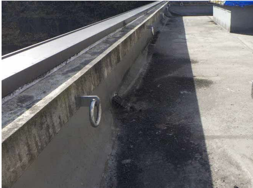
エコステーション松江 不⑭（屋根不具合箇所） 入隅部防水剥離 （全般） FL+11.0MM
