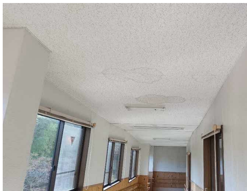
エコステーション松江 粗大ごみ処理施設棟 漏⑧（内部漏水部） 屋根からの漏水跡
