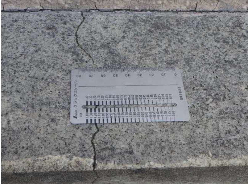
エコステーション松江 不⑪（屋根不具合箇所） 防水7ゴ 亀裂 FL+7.0M
