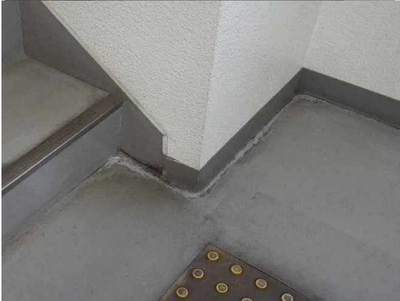
エコステーション松江 管理棟階段室 漏⑪（内部漏水部） 外部からの漏水跡 発錆確認
