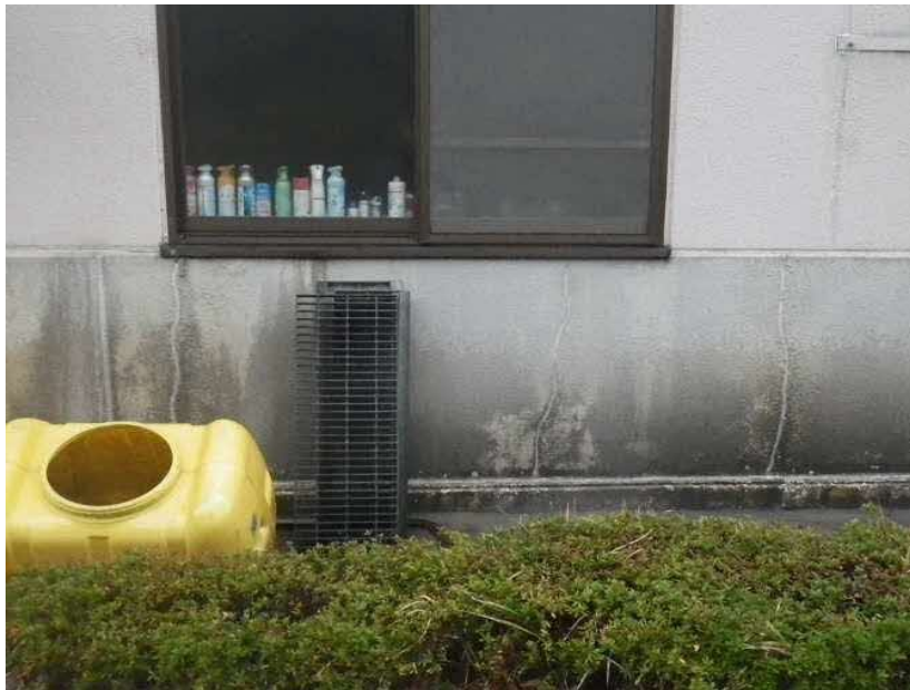
エコステーション松江 粗大ごみ処理施設棟 ④② (南面) 腰壁 □RC壁面クラック状況 ②-①通り間
