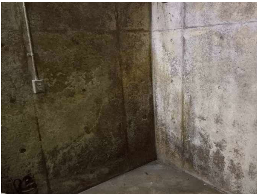
エコステーション松江 粗大ごみ処理施設棟 漏⑫（内部漏水部） 外部からの漏水（推測） B1F-A-⑤～⑥
