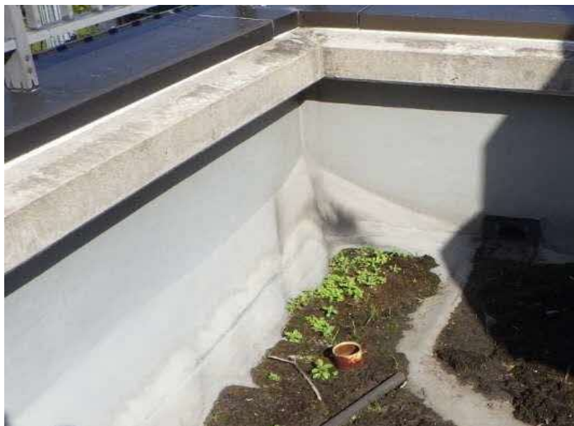
エコステーション松江 (屋根不具合箇所) 不㉚入隅部防水剥離 (全般) 土砂堆積・コケ類発生 FL+7.0M
