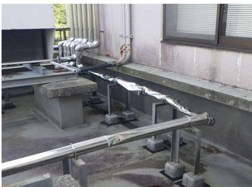
エコステーション松江 不㉛(屋根不具合箇所) 落雪によるラッキン' 破損 冷媒管養生無し FL+7.0M
