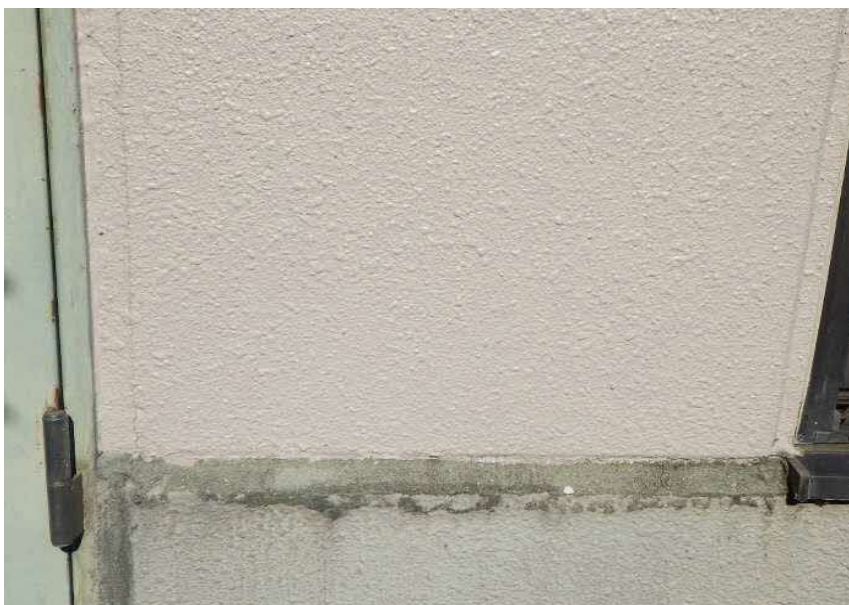
エコステーション松江 粗大ごみ処理施設棟 漏①-3（内部漏水部） シーリング部からの漏水 （ALC板） 1F-F-③-④ （拡大）
