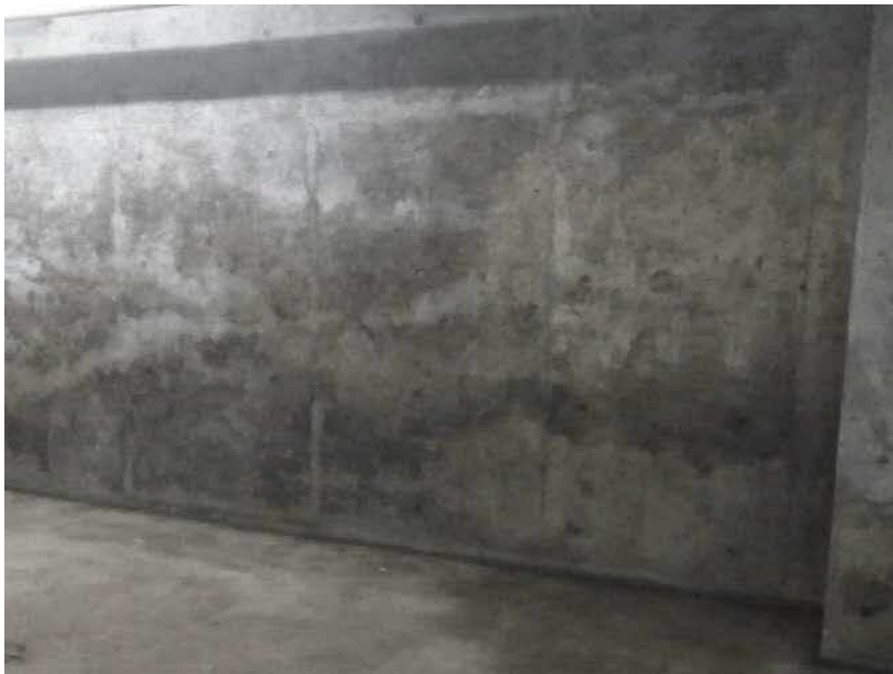
エコステーション松江 粗大ごみ処理施設棟 漏⑭（内部漏水部） 外部からの漏水（推測） コンベヤピットC B1F-F-⑦～⑧
