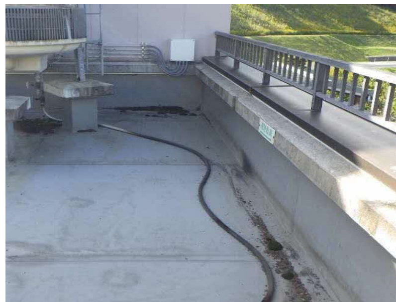
エコステーション松江 不⑬（屋根不具合箇所） 電気配線露出 屋上面へ転がし FL+7.0M
