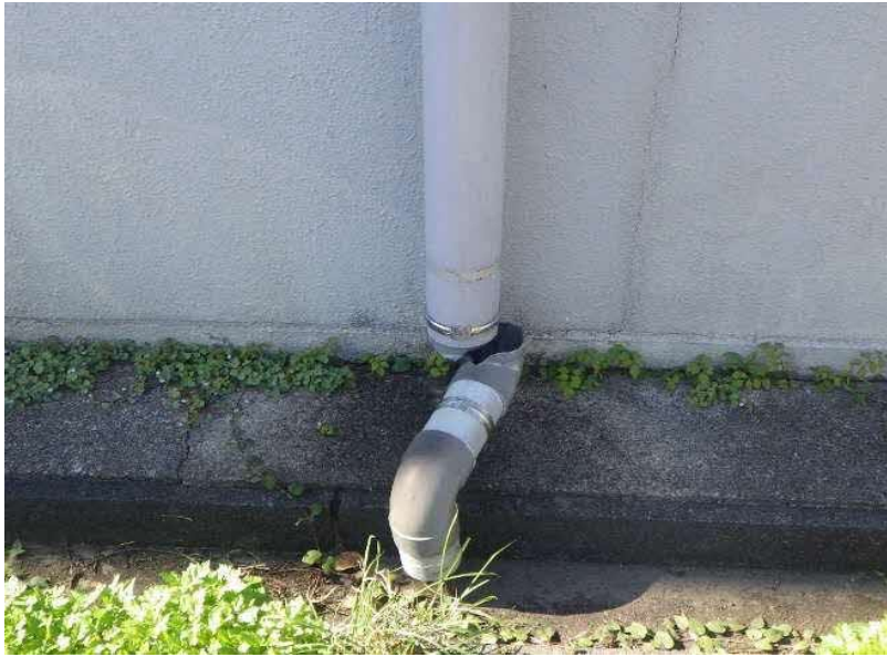
エコステーション松江 粗大ごみ処理施設棟 外④（外部その他） 周辺地盤の沈下等 東面
