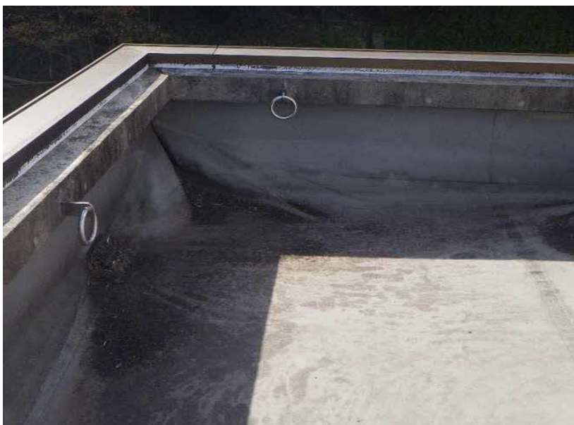
エコステーション松江 不⑯（屋根不具合箇所） 入隅部防水剥離 （全般） ルーフトレイン部 土砂の堆積 防水剥離 FL+11.0MM
