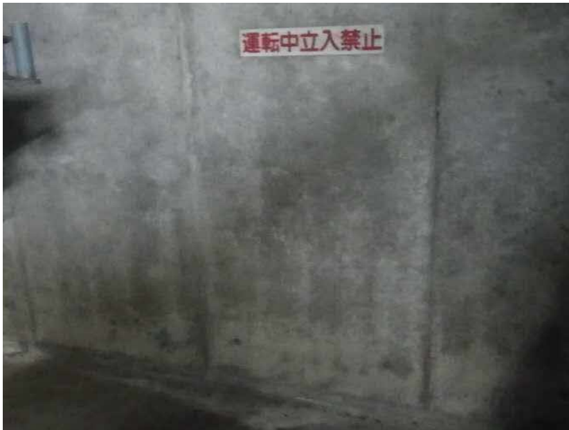
エコステーション松江 粗大ごみ処理施設棟 漏⑪（内部漏水部） 外部からの漏水（推測） コンベヤピットA B1F-F-④～⑤
