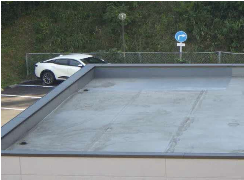
エコステーション松江 粗大ごみ処理施設棟 不④（屋根不具合箇所） シート防水の劣化 ポーチ屋根
