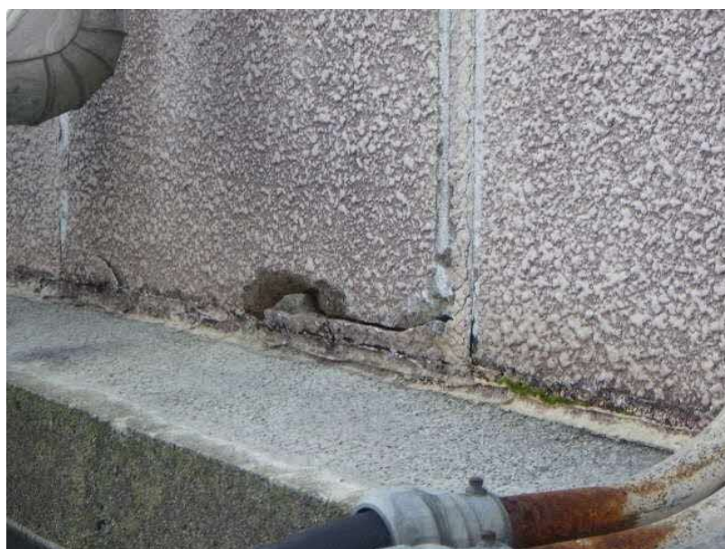
エコステーション松江 不㉜(屋根不具合箇所) ALC及び防水73' 亀裂 FL+7.0M
