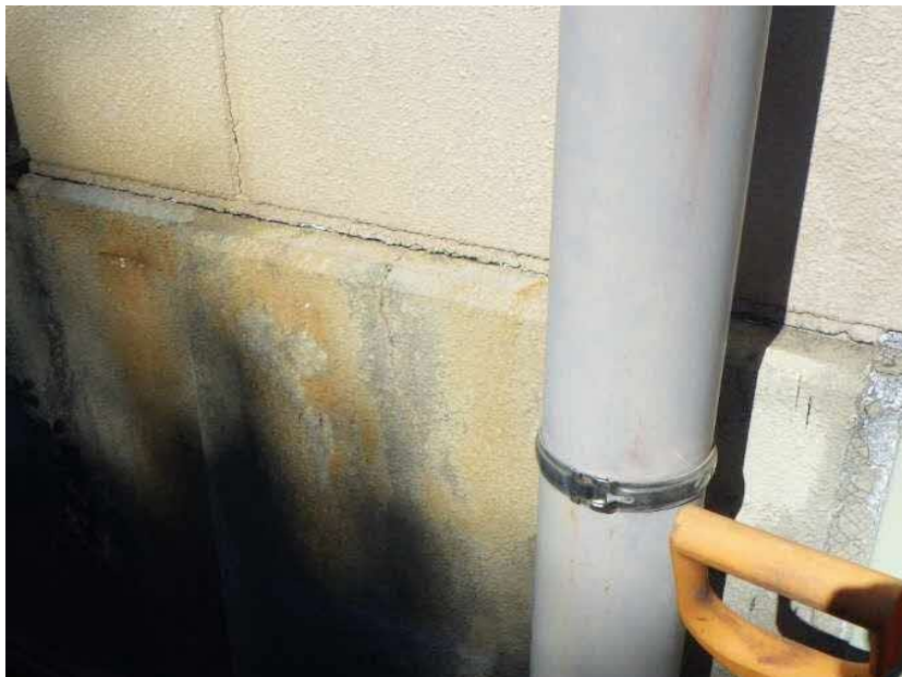
エコステーション松江 粗大ごみ処理施設棟 漏①-2（内部漏水部） シーリング部からの漏水 1F-F-③-④ （拡大）
