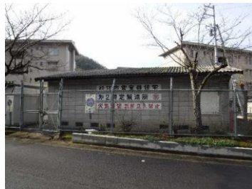
旧簡易ガスボンベ庫 (写真: 宝谷住宅)
