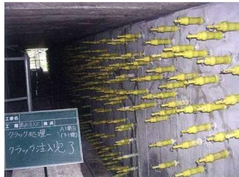
写真 1-2 ひび割れ注入状況
