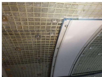
写真4 線導水工+ネット工
