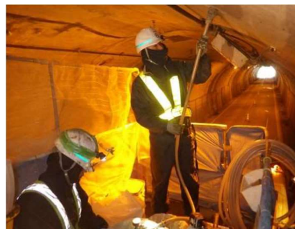
写真6 裏込注入状況
