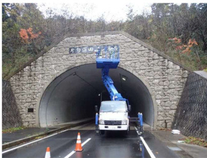
写真1 トンネル点検状況
