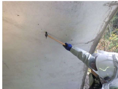
写真2 トンネル点検状況(打音検査)
