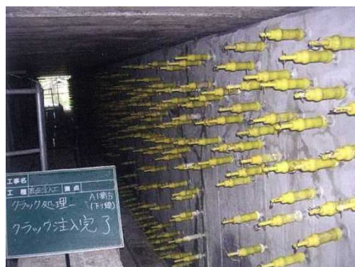
写真 1-2 ひび割れ注入状況
