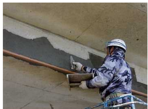
写真 1-3 断面修復状況
