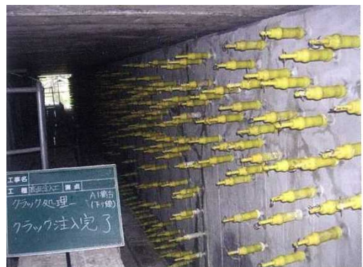
写真 1-2 ひび割れ注入状況
