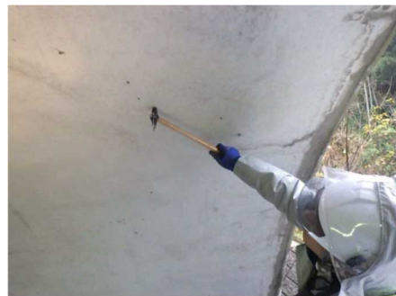
写真2 トンネル点検状況(打音検査)
