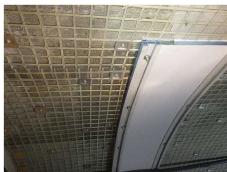
写真4 線導水工+ネット工
