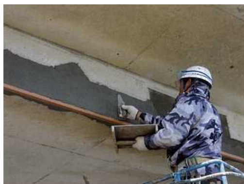
写真 1-3 断面修復状況
