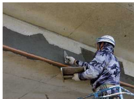
写真 1-3 断面修復状況
