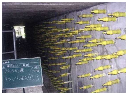
写真 1-2 ひび割れ注入状況
