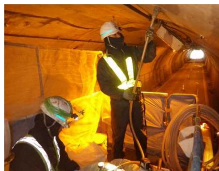
写真6 裏込注入状況
