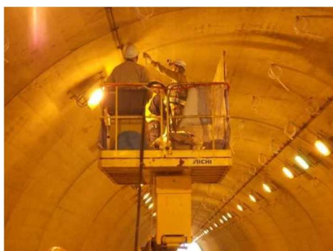
写真5 裏込注入状況
