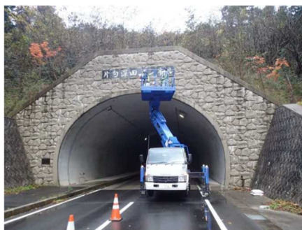
写真1 トンネル点検状況
