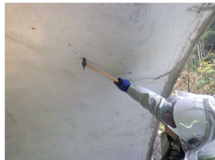
写真2 トンネル点検状況(打音検査)
