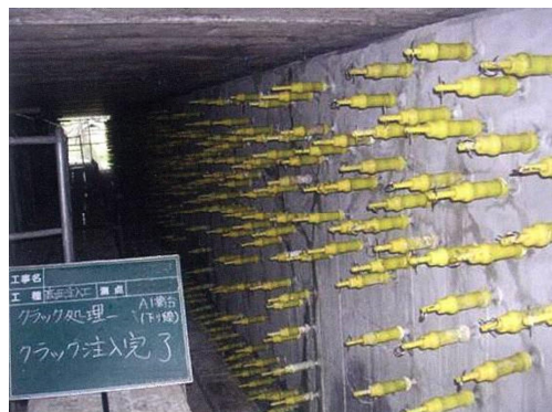
写真 1-2 ひび割れ注入状況
