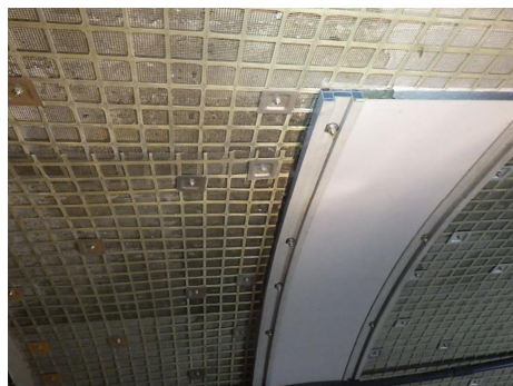
写真4 線導水工+ネット工
