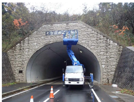
写真1 トンネル点検状況
