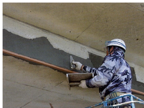
写真 1-3 断面修復状況
