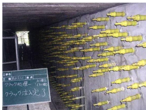
写真 1-2 ひび割れ注入状況
