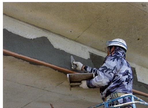
写真 1-3 断面修復状況
