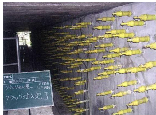
写真 1-2 ひび割れ注入状況
