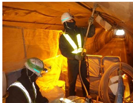
写真6 裏込注入状況
