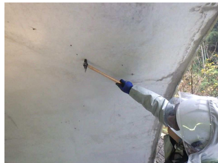
写真2 トンネル点検状況(打音検査)
