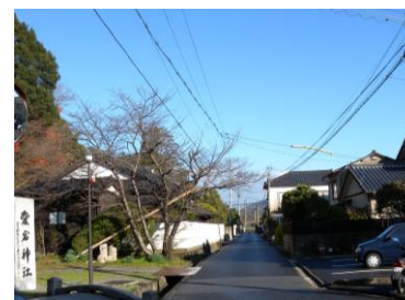
電線類が重なり合い景観を阻害している
