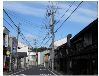
道路には、電線が重なり合い良好な景観を阻害しているとともに、電柱が林立して歩行者は歩きにくい。
