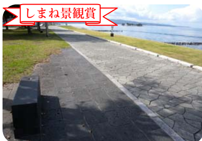
しまね景観賞 型押モルタル平板・自然石張(岸公園) 央道湖や山並に調和すよう、落ち着いた印象の素材・色彩を用いている。
