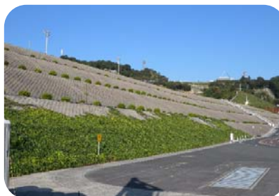
法面⑥ つる性の植物による被覆や植栽樹による緑化で、構造物による圧迫感を和らげている。
