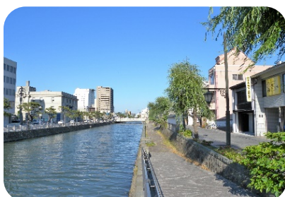
石積護岸(京橋川) 対岸の景観との調和に配慮している。
