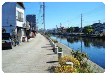
ボード((市)天神川北1号線) 柵の代わりにボードを設置することで河川との境界が曖昧になっている。河川空間と一体となり、開放感が増している。
