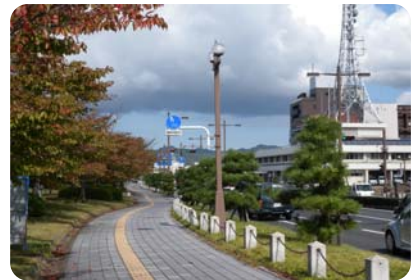
ボード・植栽(穴道湖通り) 植栽帯や駒止等で歩車道を区分することで、横断防止などの心理的な抑止効果を発揮する。
