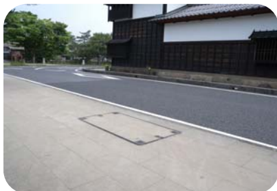
(松江歴史館前) 蓋の表面を舗装材と同一素材で仕上げることで、異質感を少なくしている。
