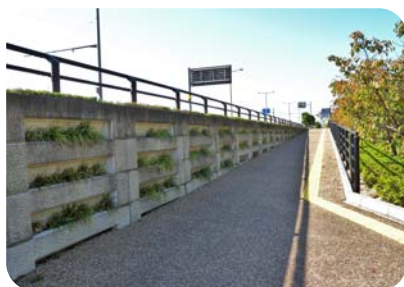
植栽ブロック(末次町) 擁壁が緑化され、快適な歩道空間となっている。
