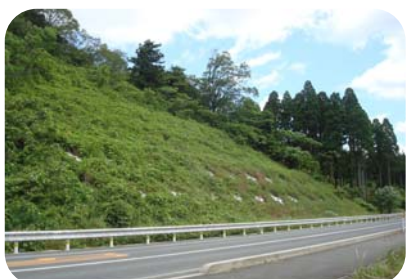
法面⑦ 緑化への配慮がなされているため、年月が経過して受圧板が目立たなくなっている。
