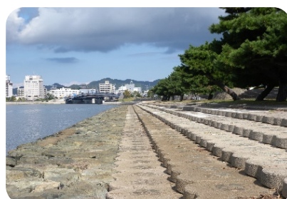
ブロック等による階段護岸(宍道湖) 水面とコンクリートブロックが自然石の捨石で柔らかくつながっている。階段状で、湖面や夕日、花火などの視点場となっている。
