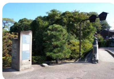
案内標(亀田橋橋詰) 本体に自然石を使用。道路標識の支柱にはダークブラウンを用い、目立たなくしている。
