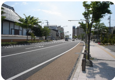
ボード(駅通り) 防護柵を使用せず、ボードを設置することで道路空間に広がりが見られる。歩車道間の逸脱防止についても検討が必要となる。
