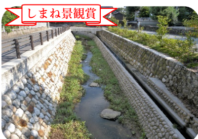
石積護岸(広岡川) 改修前の護岸に使われていた石を使用することで、神社のある風景になじんでいる。
