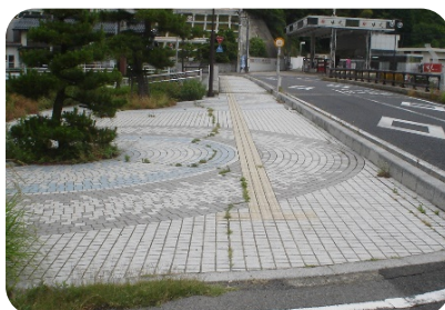
タイル張(鹿島町本郷橋橋詰) 彩色の自由度の高さを生かして橋詰のスポットを明るく演出している。
