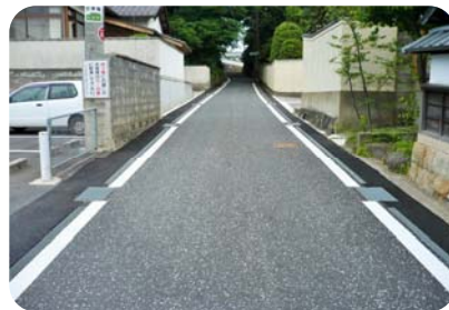
ロードアスファルト舗装((市)北堀7号線) 白色の砕石を散布・圧入して仕上げられている。路面が明るく感じられ、観光ルートの明示にも役立っている。
