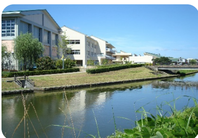
矢板護岸(北田川) 手入れの行き届いた緩斜面護岸。建築物と川を柔らかくつないでいる。
