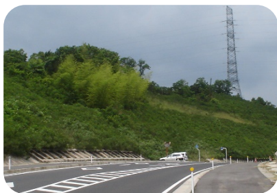
法面① 長大な法面も植生を施すことで時間の経過とともに周囲の景観に馴染んでくる。
