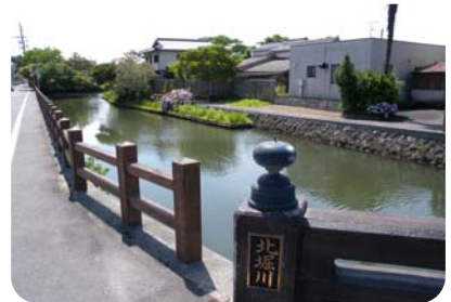
転落防止柵((市)北田大手前線) 柵の高欄と調和したデザインの防護柵。橋と通りの一体感が生まれる。
