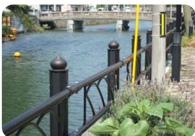
転落防止柵((市)東本町東西4号線) 擬宝珠を載せた支柱が堀川の歴史性を感じさせる。
