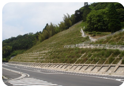
法面③ 長大な法面は勾配をできるだけ緩やかにし、緑化可能な工法を採用する。
