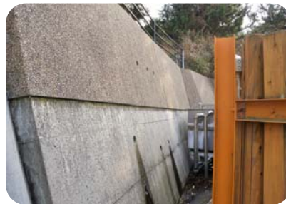
コンクリート擁壁の修景(玉湯町玉造) 前面を木材で隠すことにより、構造物の圧迫感を軽減している。可視部分には、川砂利を塗りつけて美装化している。
