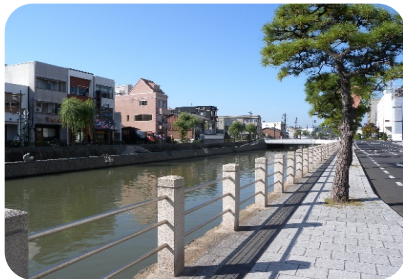
転落防止柵(京橋川通り) 周辺施設と質感を調和させることで、まとまり感のある景観が形成できる。
