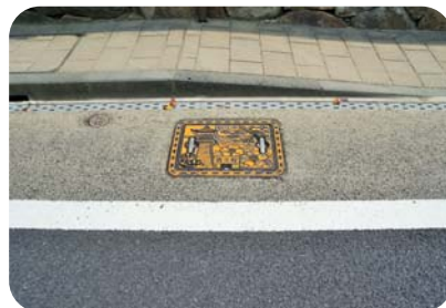
(塩見縄手) 伝統美観保存区域であり、消火栓の表示が困難であるため、適度な彩色で視認性を高めている。
