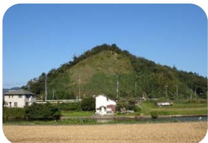
法面④ 植生の定着により、周辺の斜面との一体化が進んでいる。
