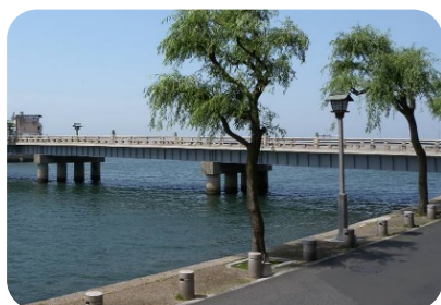
ポール灯((市)大橋川北沿1号線) 橋梁の照明施設のデザインや街路樹の雰囲気と調和する街路灯。
