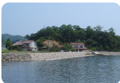
石積護岸(中海) 自然石を基調とした護岸は、周辺の景観に調和しやすい。
