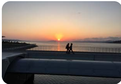
転落防止柵(天神川水門) 透過性の高いデザインにより、水辺との距離感が縮められている。道路からの眺望も遮らない。
