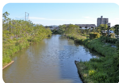
矢板護岸(中川) 緑の多い護岸は、町なかであっても生き物の存在を感じさせる。
