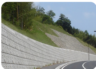
大型ブロック(法吉町) 化粧型枠仕上げを採用することによって圧迫感を軽減している。
