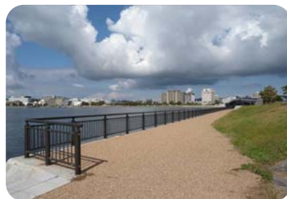
樹脂系舗装(白潟公園) 舗装面の明るい色彩が、背景となる都市景観と調和し、賑わい感を演出している。
