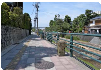
転落防止柵((市)玉湯川筋線) 河川への眺めを阻害しないガードパイプ。控えめな色彩で統一されている。
