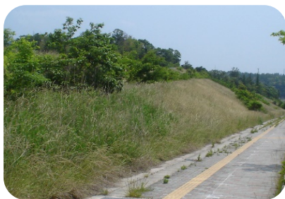
法面② 高さが低く、低勾配の法面は圧迫感が少ない。緑化により周囲の景観になじんでいる。
