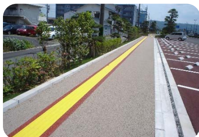
樹脂系舗装(夕日スポット駐車場) 明るい色調が賑わい感を演出している。点字ブロックのコントラスト向上にも配慮されている。
