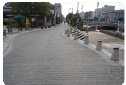
ボード(カラコロ広場) ボード間からの転落に対する注意を喚起するため、ボードの周囲に点字ブロックを配している。
