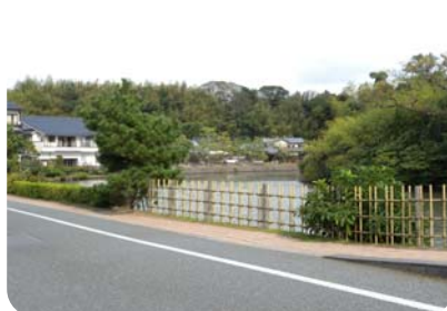
植栽・竹垣((市)図書館西通線) 石垣が史跡であるため防護柵は埋め込めないが、低い植栽や歩道の明示と竹垣により、安全性と周辺景観との調和を両立している。
