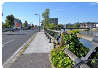
転落防止柵(城山西通り) 木製梁を採用、上部を川側へ倒すことで歩行空間を広く見せている。
