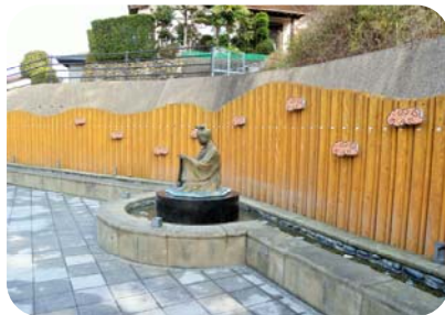
コンクリート擁壁の修景(玉湯町玉造) 前面を木材で隠すことにより、構造物の圧迫感を軽減している。可視部分には、川砂利を塗りつけて美装化している。
