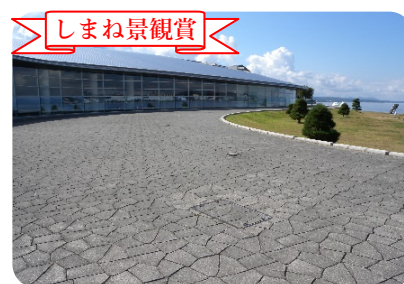
型押しモルタル平板張(県立美術館) 穴道湖と芝生に調和する石張風とし、目地の陰影により抑揚のない平面に変化を与えている。
