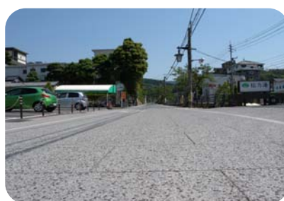
半たわみ性舗装(玉造温泉街) 重量車輛に対して耐久性が高く、観光バスの乗り入れに配慮している。舗装に目地を入れて石畳風の外観としている。
