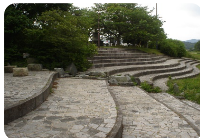
自然石による階段護岸(意宇川) 河川断面に余裕があれば、水に近づける護岸構造を採用したい。
