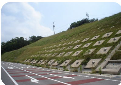
法面⑤ 受圧板の規則的な配置と植生により異質感を軽減している。
