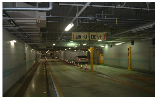
松江駅前地下駐車場
