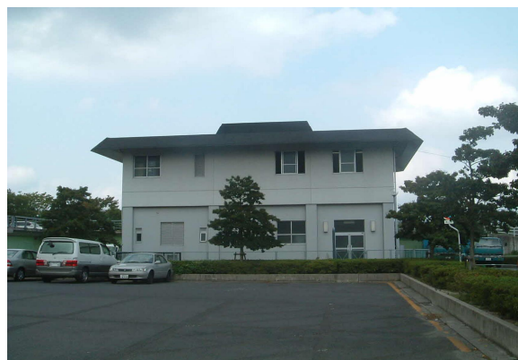
向島ポンプ場
