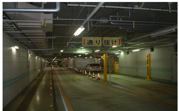
松江駅前地下駐車場
