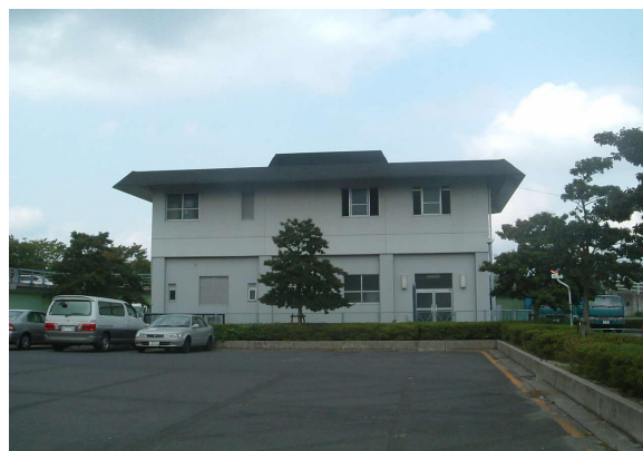
向島ポンプ場
