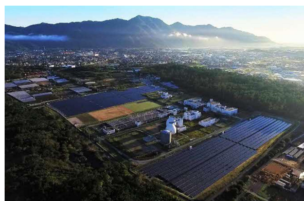
宍道湖西部浄化センター
