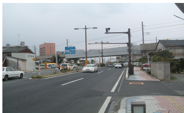
山陰本線松江駅付近連続立体交差化事業 (国道9号線との交差[袖師町])
