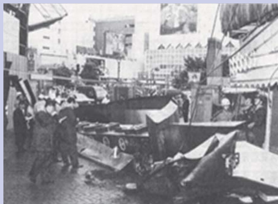
台風で落下した時の様子
