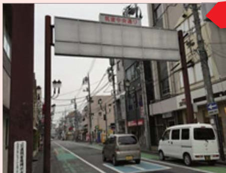
撤去されずに残されたアーチ看板
