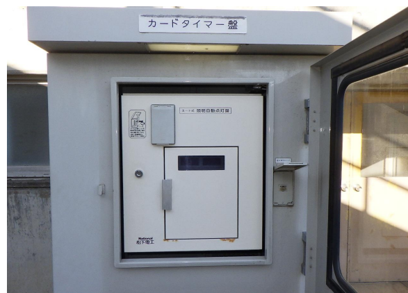
野球場照明操作盤の更新
