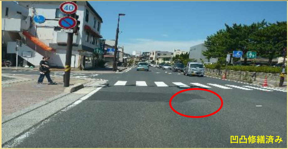
▲改善後写真 After
