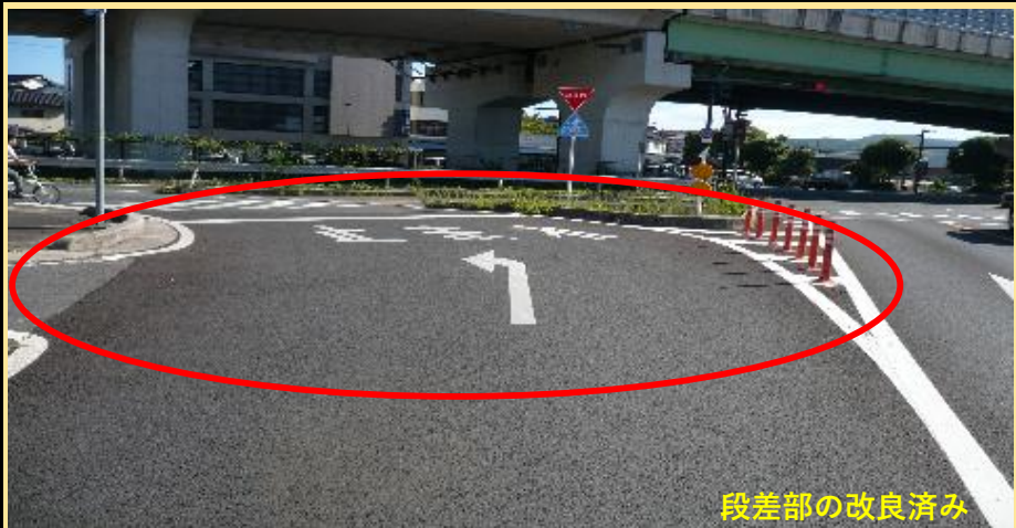
▲改善後写真 After
