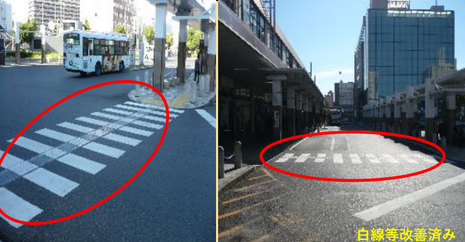
▲改善後写真 After
