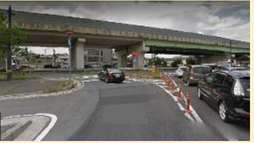
▲改善前写真 Before
