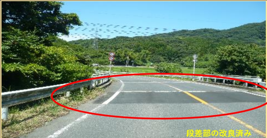
▲改善後写真 After
