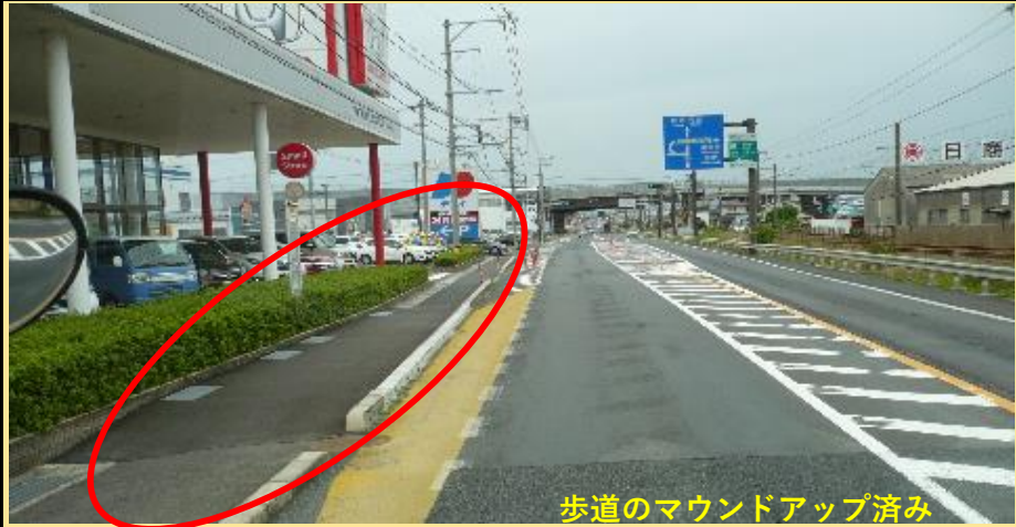
▲改善後写真 After
