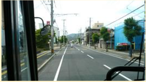
▲改善前写真 Before
