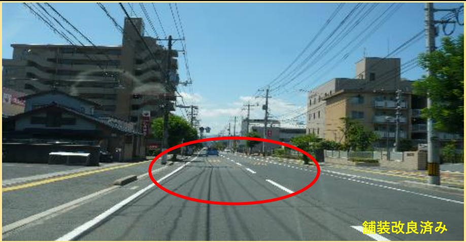
▲改善後写真 After
