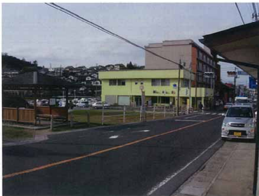
バス駐車帯の幅が狭く、後続車両が停滞する
