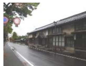
惣門橋通り南側から望む (取り壊し前)
