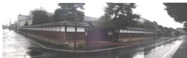
歴史的な外観を持つ連続した堀(取り壊し前)
