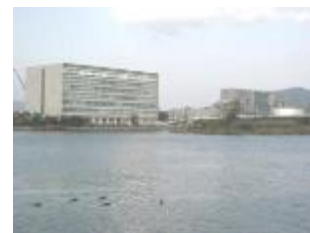
松江地方合同庁舎
