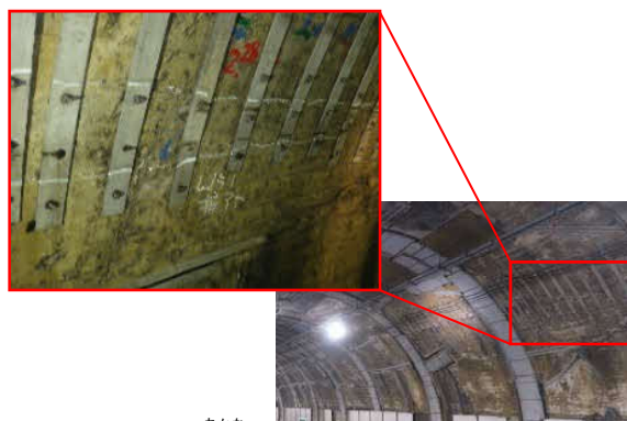
【写真②】赤名トンネルにおける車両の接触による損傷
