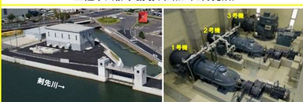
上追子川排水機場(令和3年9月完成)
