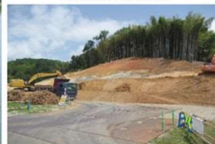
河川土工(掘削)の整備状況
