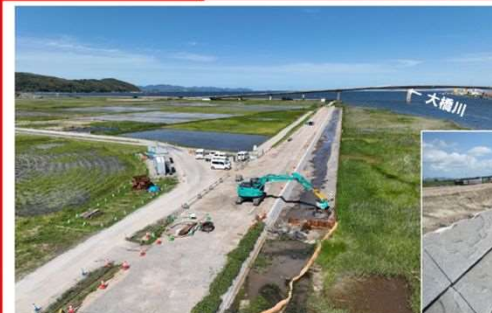
護岸前面の埋め戻し状況
