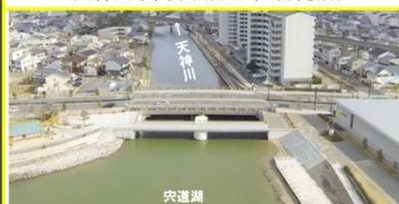
天神川水門(平成27年1月完成)
