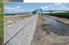
護岸前面の埋め戻し状況
