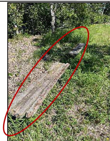
既存ベンチ(腐朽)
